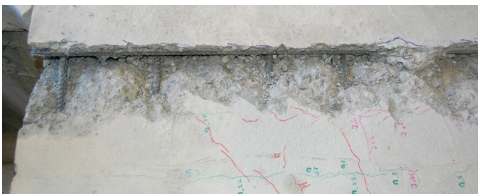
(d) Overhang edge after removal of loose concrete
